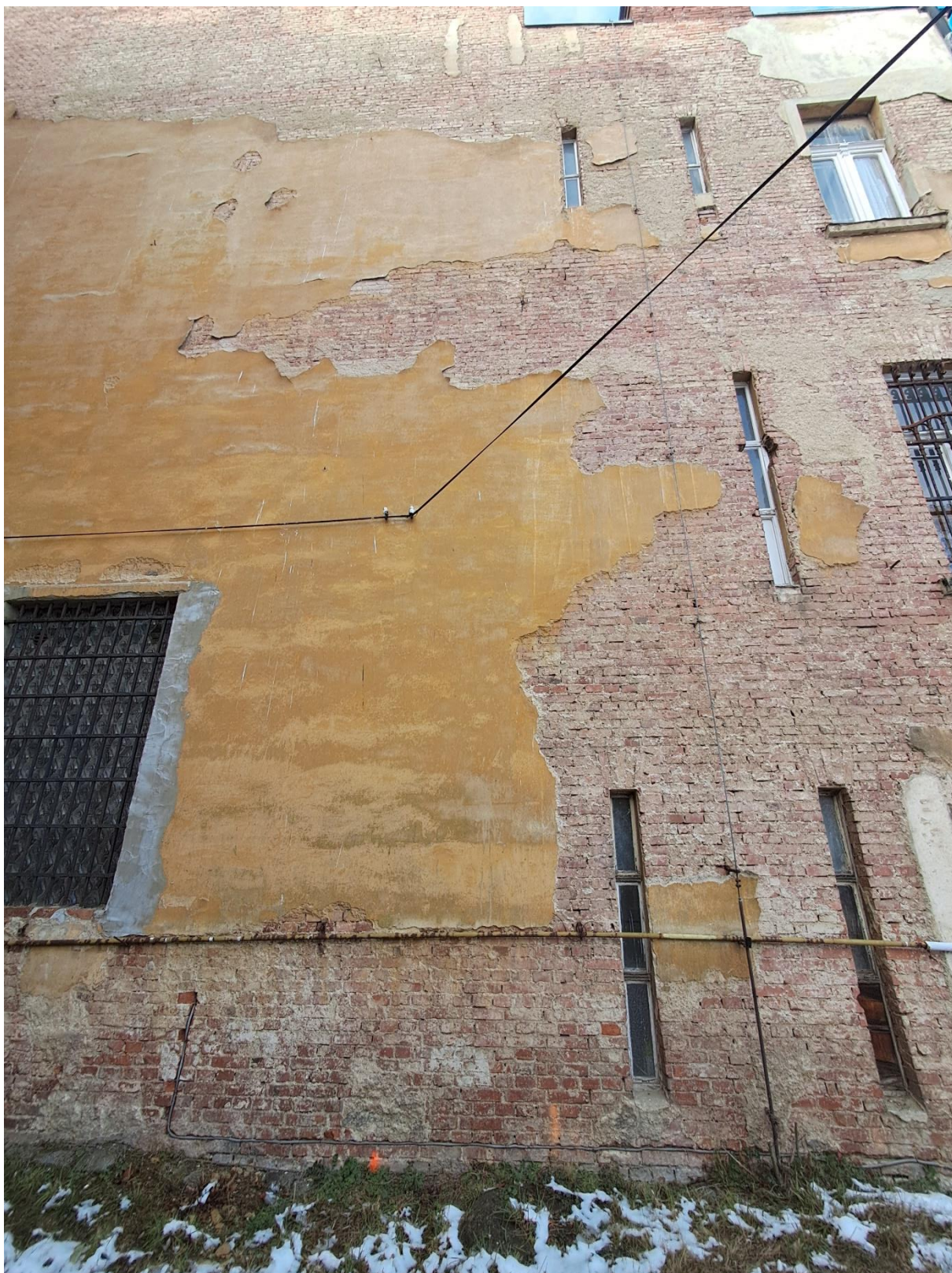
viditelné značky: vlevo – hranice pozemku dle GP, vpravo venkovní část přístavby (zalícování na odskok budovy ve 4. NP
