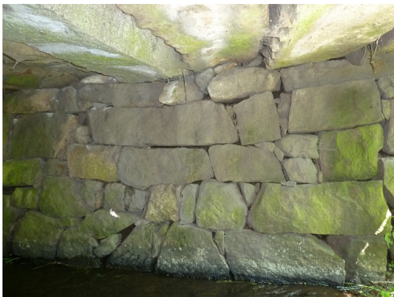
Podhled nosné konstrukce a pravá opěra
