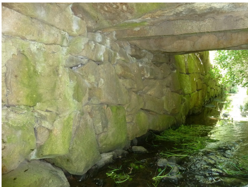
Levá opěra, podemletá v úrovni vody
