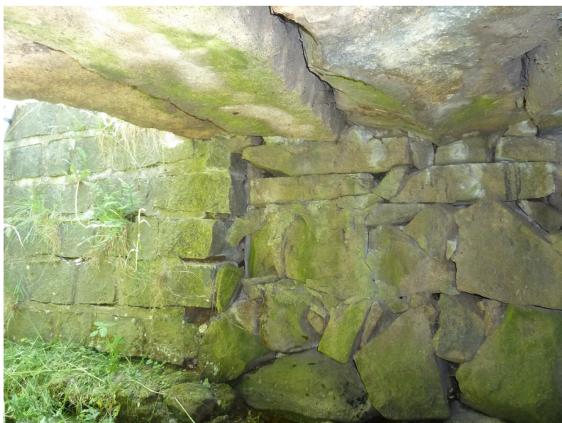
Navázání pravé opěry na regulační zeď na výtoku
