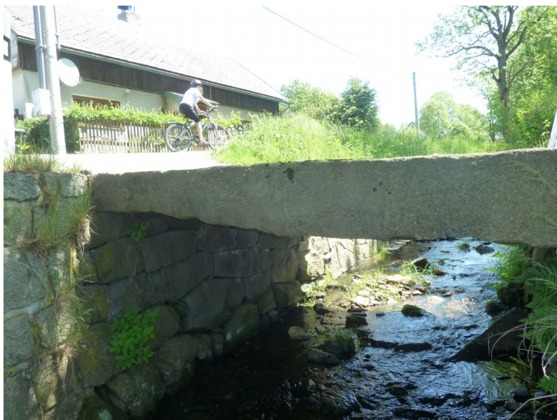
Výtokový kamenný kvádr a pravá opěra
