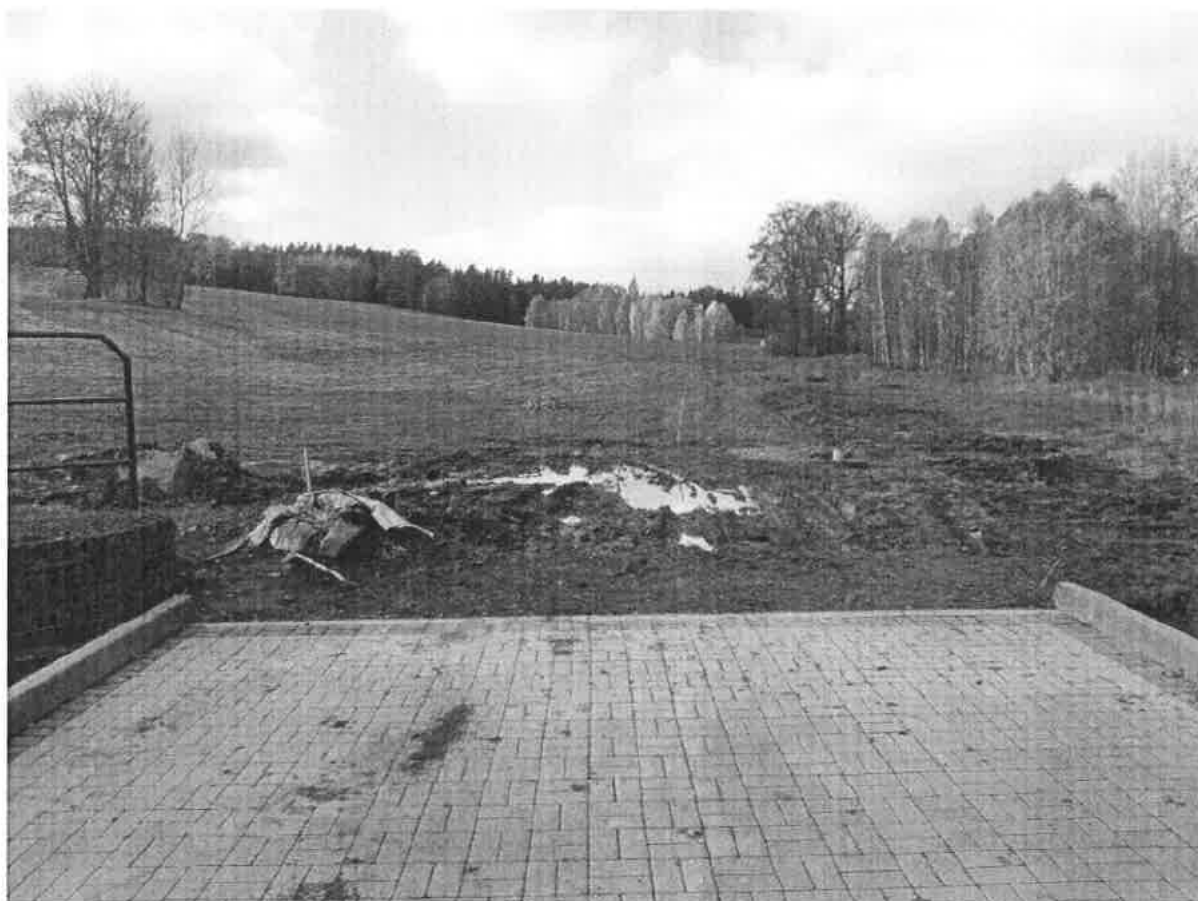
ZL č. 5 – zvodnění stávající cyklostezky vyvěrajícím pramen – nutná drenáž a propustek
