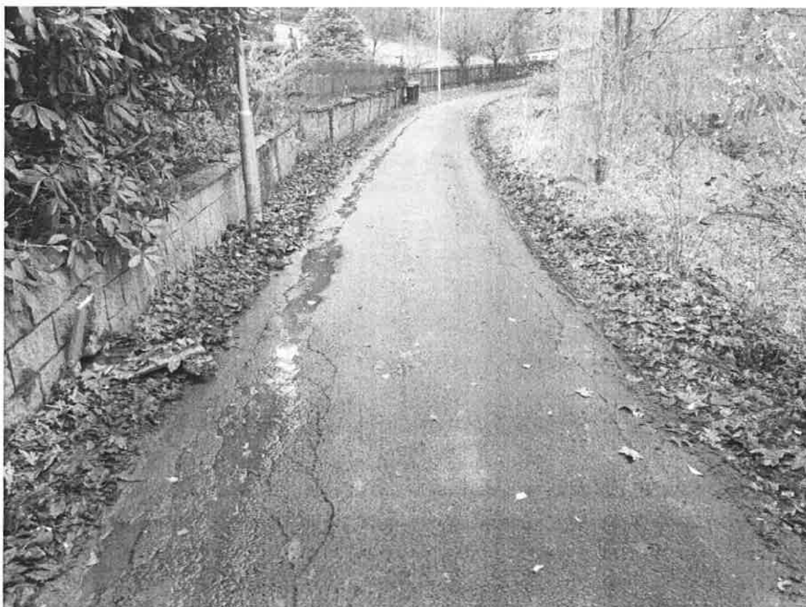
ZL č. 5 – zvodnění stávající cyklostezky vyvěrajícím pramen – nutná drenáž a propustek
